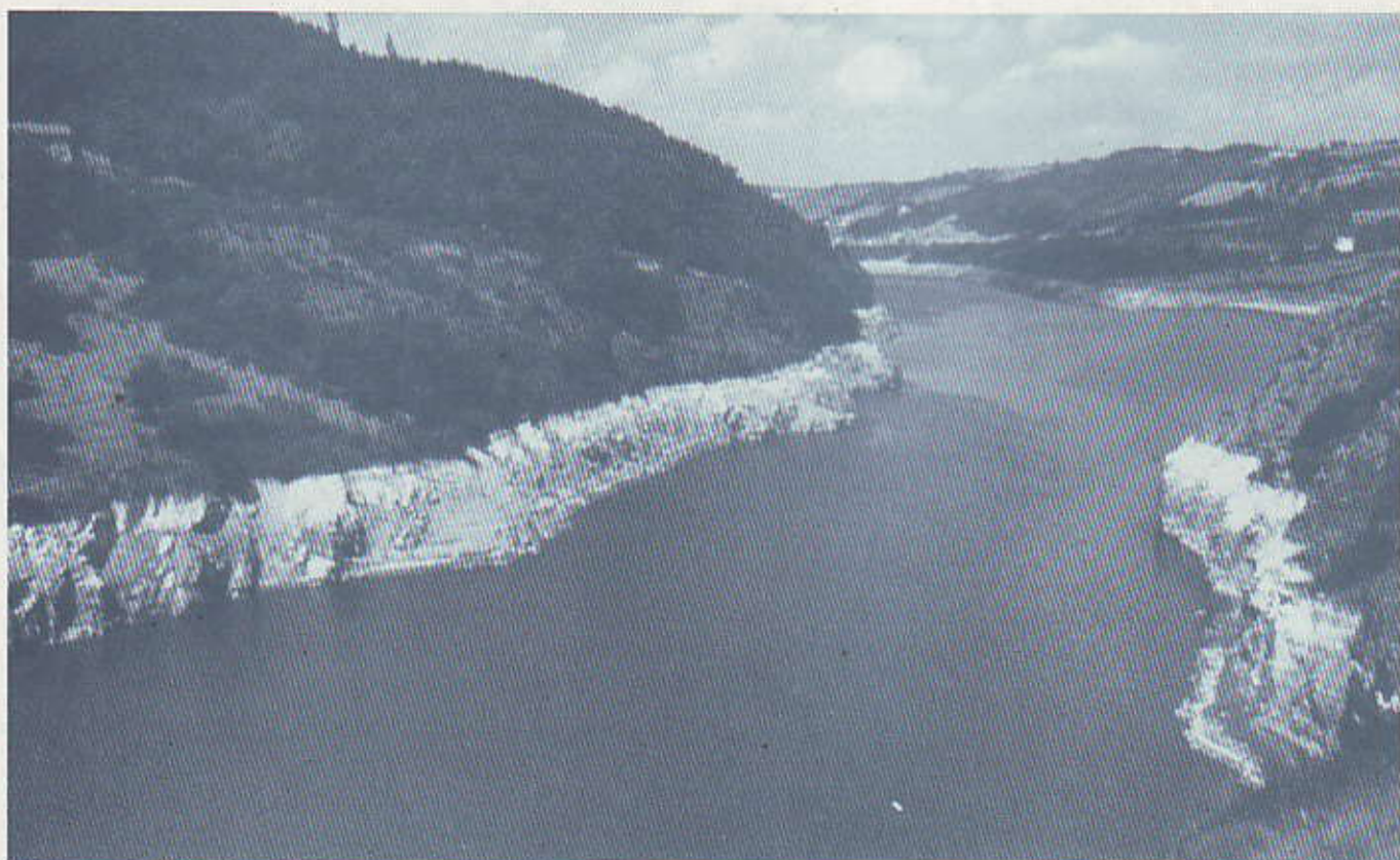
Retenue avec marnage lié au soutien d'étiage.
