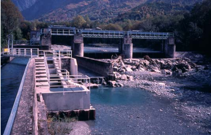
Barrage de la Trinité sur la Séveraise (05) avec sa passe à poissons Crédit photo : Jacques Pulou
