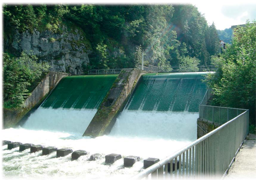
Le barrage du Refrain (25) déverse environ 20m 3 /s car l'usine ne peut turbiner que 25m 3 . L'excédent d'eau passe dans le lit court circuité sur environ 3 km - Août 2006. Crédit photo : Jean Wencker
