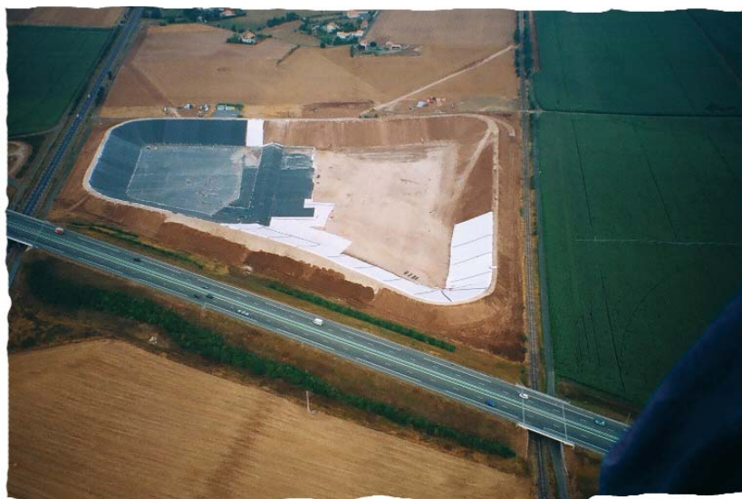
R etenne dite de Oulmes-Nord (85) en construction : pose de la géomembrane (713 000 m 3 ) Crédit photo : Jean-Jacques Guillé
