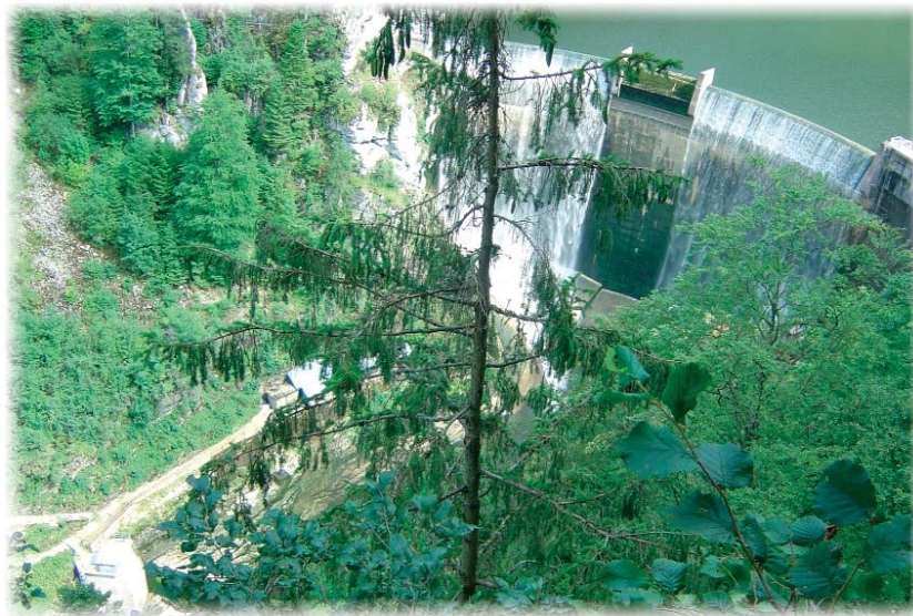
Chute du barrage du Châtelot (25) de 74 m. La turbine est située en bas à gauche. Crédit photo : Jean Wencker
