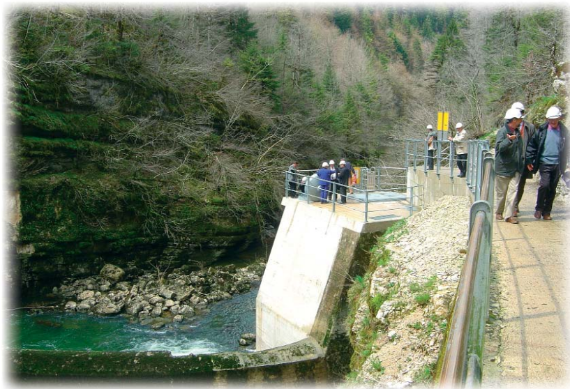
La centrale est située à 50 m en aval du barrage. La mini-voûte sur la gauche permet de briser l'énergie des eaux en cas de crue. Crédit photo : Jean Wencker
