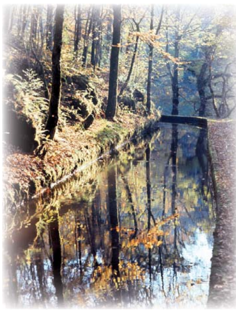
Le canal des Jarrauds, à St Martin Château (23). La rectification des berges et la perte de sinuosité caractérisent les aménagements de cours d'eau. © Delangle
