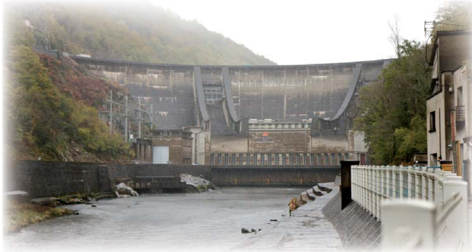
Le barrage du Chastang sur la Dordogne en Corrèze. Haute de 75 mètres, cette usine hydroélectrique d'une puissance de 283 Mégawatts a été mise en service en 1951. © Bernard ROUSSEAU
