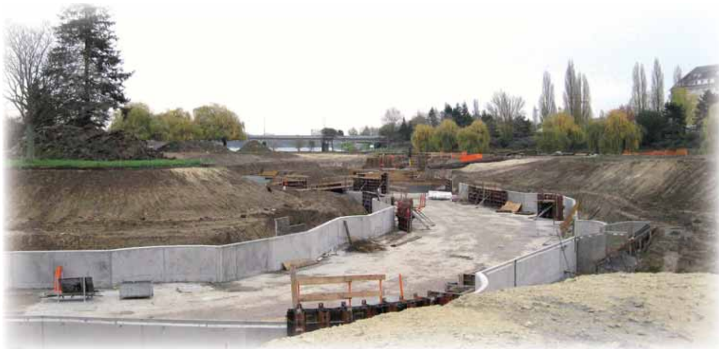
Une rivière de contournement est un palliatif à l'existence d'un barrage. Ici, un bras de la rivière de contournement du barrage de Rochepinard à Tours en cours de construction. © Josselin De Lespinay
