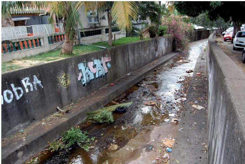
Ravine de la Glacière, cours d'eau chenalisé dans la traversée de St Denis de la Réunion. © Michel LASSUS
