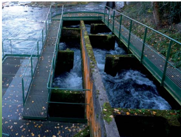
Barrage et passe à poissons de la centrale de Las Rives à Varilhes sur l'Ariège. © Jacques Pulou
