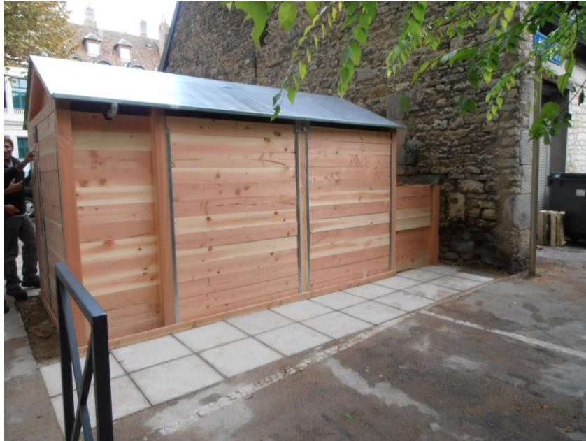
Chalet de compostage installé dans les quartiers d'habitat dense de Besançon 21
